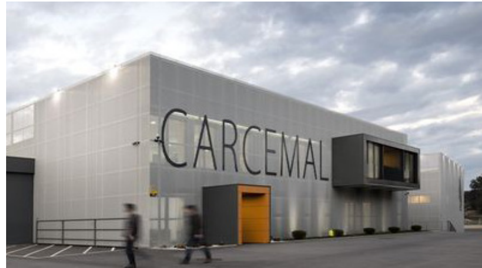
промышленное здание/ Proj3ct, Барселуш, Португалия
